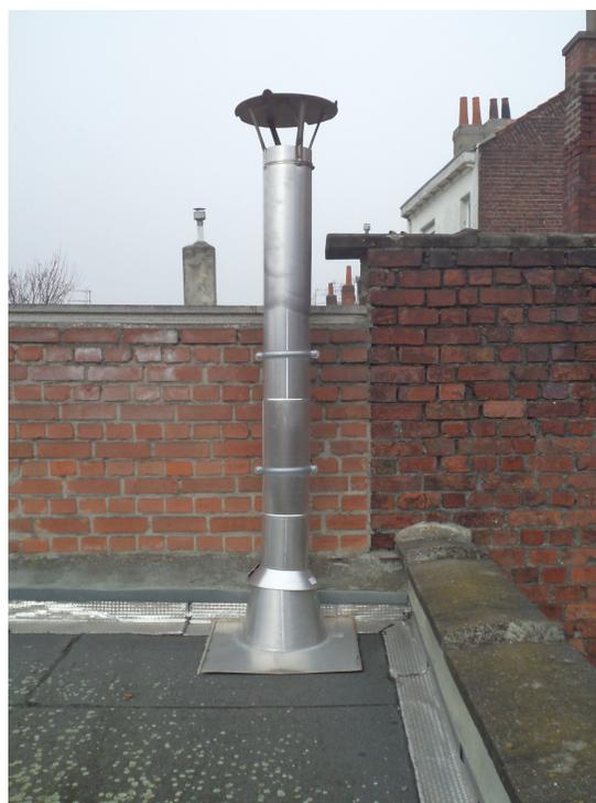
FIGURE 16 – sortie des fumées à l'extérieur
